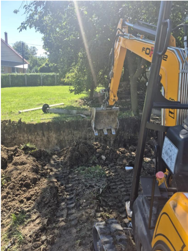
A fogas árokásó kanál munka közben. A fogak nélkül kötött talajba nem lehet behatolni.
