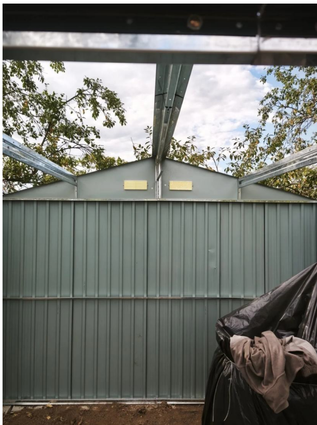
A tetőszerkezet belülről, gerincmerevítővel.
